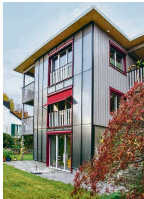
Système solaire sur la façade sud.
